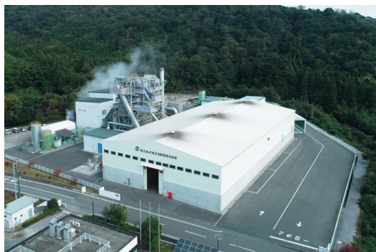
木質バイオマス発電（島根県松江市）
